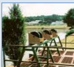
Levage de vanne
